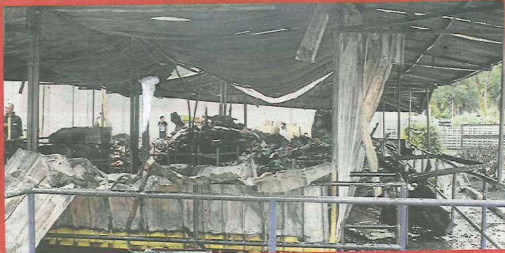
Kabin yang dijadikan tempat letak pelbagai kelengkapan haji musnah dalam kebakaran di Kompleks Tabung Haji Kelana Jaya, semalam.
